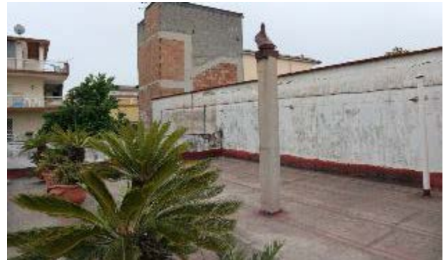
Viste del lastrico solare
